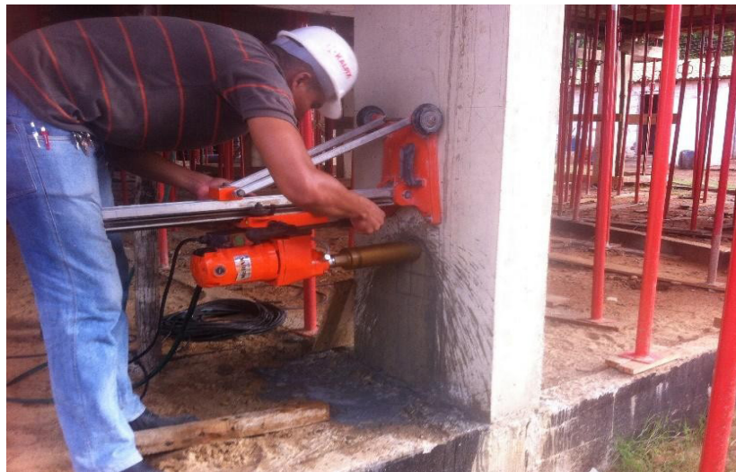
Figura 5 – Início da extração dos testemunhos cilíndricos
