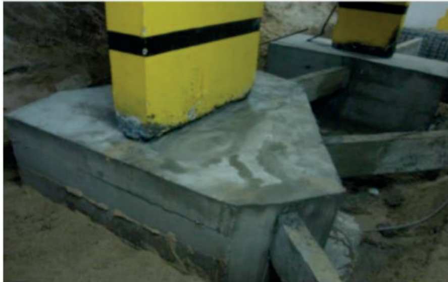
Figura 7 – Bloco finalizado e impermeabilizado
