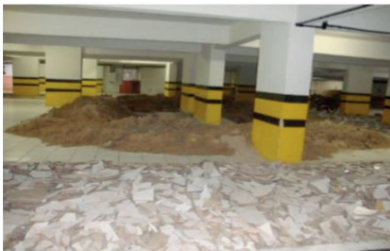
Figura 2 – Demolição de piso, contrapiso e escavação
