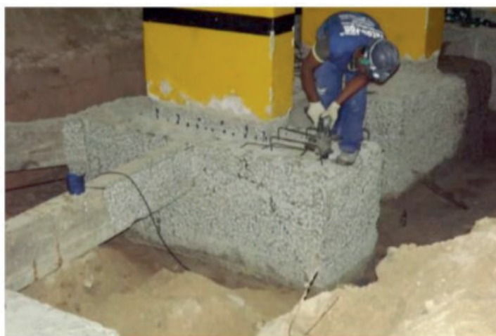
Figura 5 – Execução de furação para ancoragem da armação de reforço
