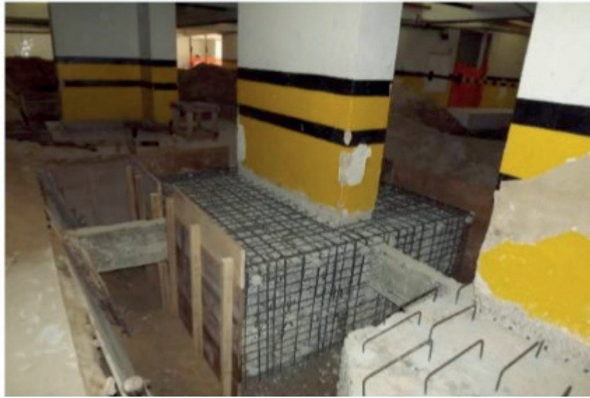
Figura 6 – Bloco com armadura de reforço
