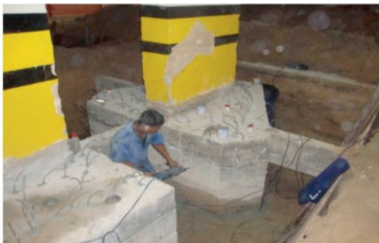
Figura 4 – Execução de furos e ancoragem das mangueiras
