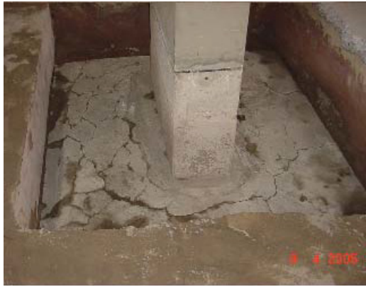
Figura 1 – Fissuração blocos.
