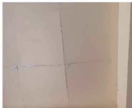
Foto 06 – Pátio em frente aos banheiros. Teto. Fissuras.
