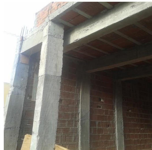
Figura 6-a: Pilar apresentando vazios no concreto
