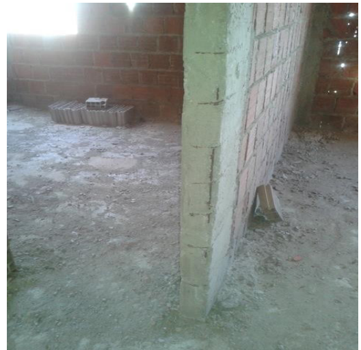
Figura 9-b: Pilar sem cobrimento
