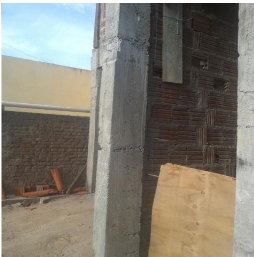
Figura 6-a: Pilar apresentando vazios no concreto
