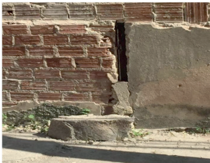
Figura 8 – Pilar concretado com madeira.
