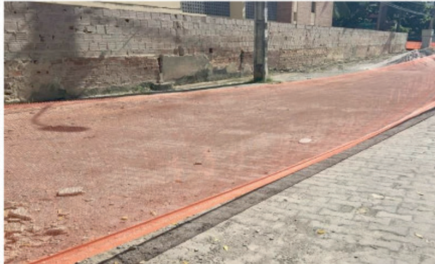
Figura 6 – Muro com risco de desabamento com área isolada.
