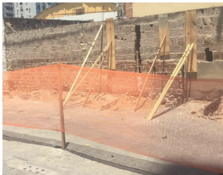
Figura 11 – Reconstrução do pilar.
