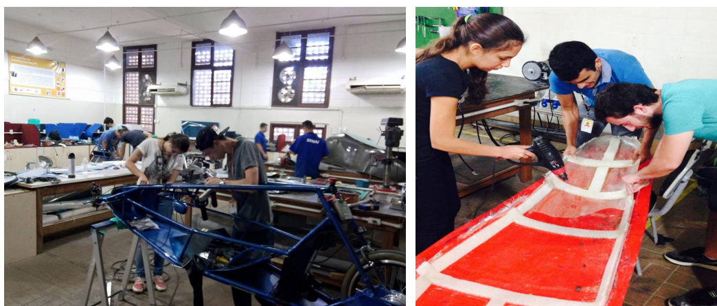
Figura 5 – Fases da construção do protótipo
