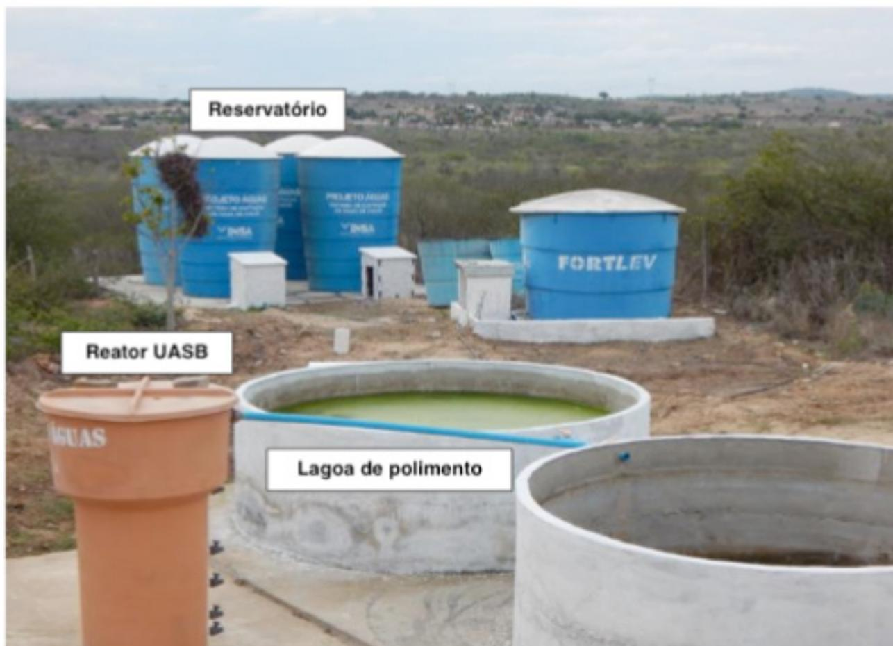
Figura 2 – Sistema de tratamento de esgoto para reuso agrícola implantado na Sede administrativa do INSA, Campina Grande (PB).
