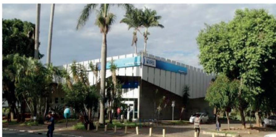
Figura 02 – Fachada frontal da Agência do Banco do Brasil.
