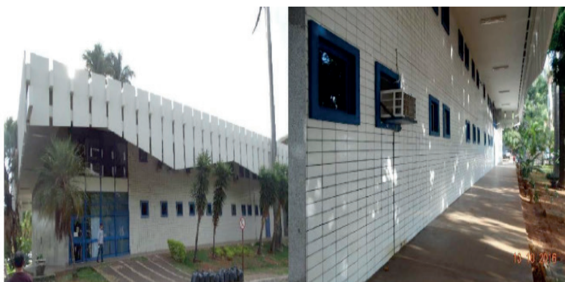
Figura 03 –Revestimento gail nas fachadas leste (esquerda) e oeste (direita).
