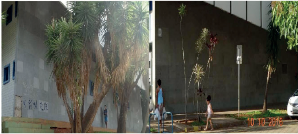
Figura 04 –Revestimento em granito nas fachadas norte (esquerda) e sul (direita).
