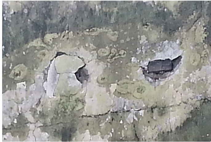
Figura 8 – Desagregação
