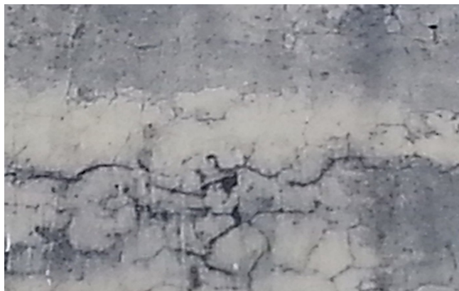
Figura 7 – Fissuras mapeadas
