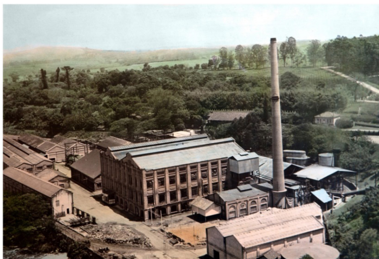
Fig. 4: Usina (Engenho Central) da Ubasá no final da década de 1960.
