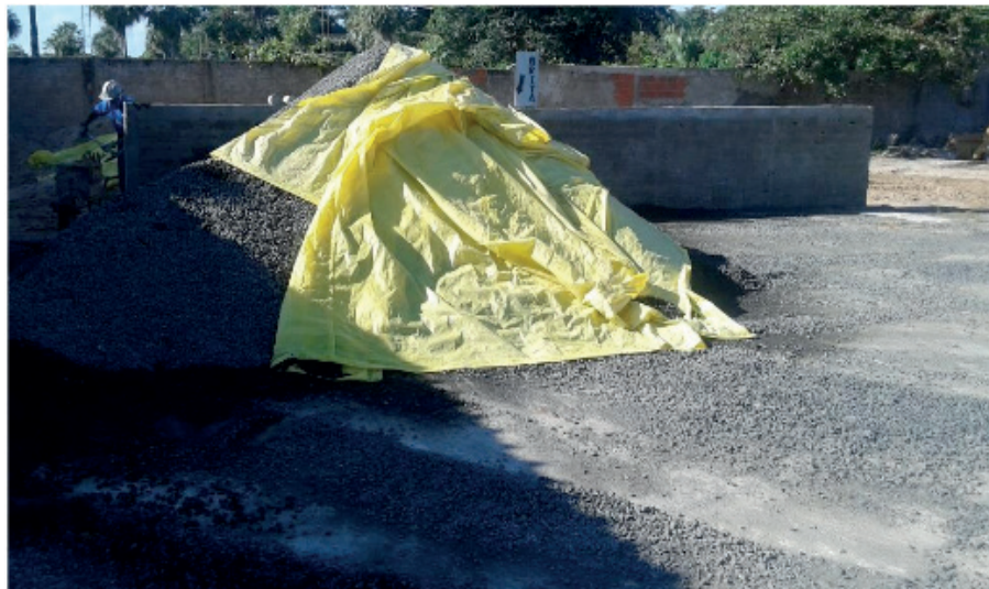
Figura 10 – Agregado graúdo coberto com lona/
