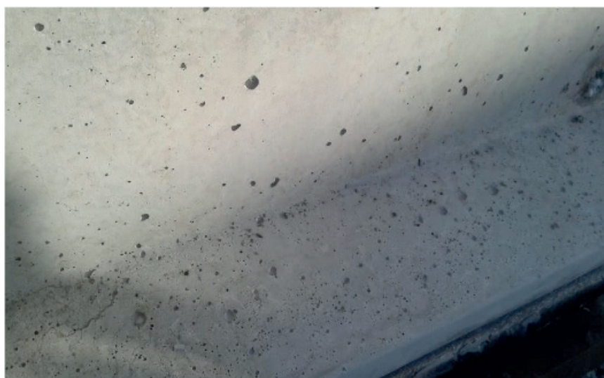
Figura 5 – Bolhas Superficiais/ Fonte: Autor
