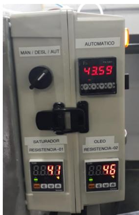
FIGURA 5 . Painel elétrico de comando
