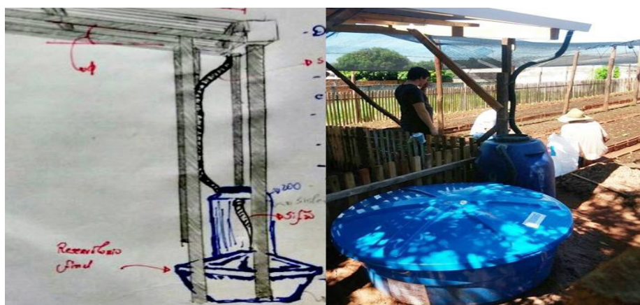
Figura 11 – Esboço e estrutura do reservatório
