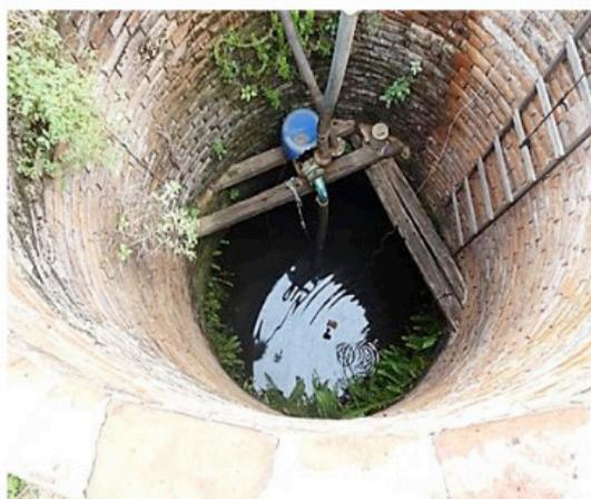
Foto 06 – Visão externa do cacimbão de tijolos (alvenaria)
