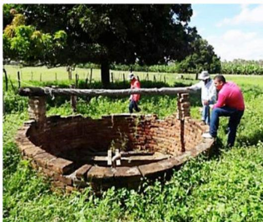
Foto 05 – Visão interna de cacimbão de tijolos (alvenaria)
