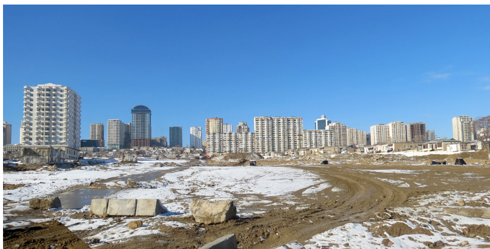
Figura 12. Sovetsky Area, em demolição.
