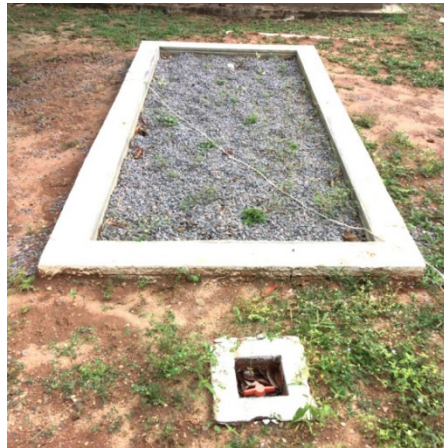
Figura 2. Vista superior sistema alagado construído.
