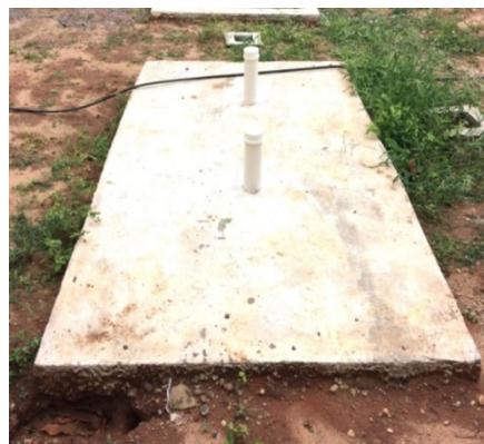
Figura 1. Vista superior do tanque séptico.
