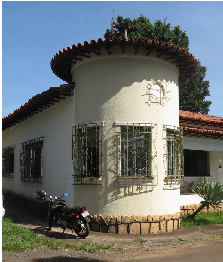
Figura 03: Torre do antigo jardim de inverno. Notar a segmentação das aberturas, a altura da torre e as saliências nos parapeitos das janelas. Foto: André Frota Contreras Faraco.
