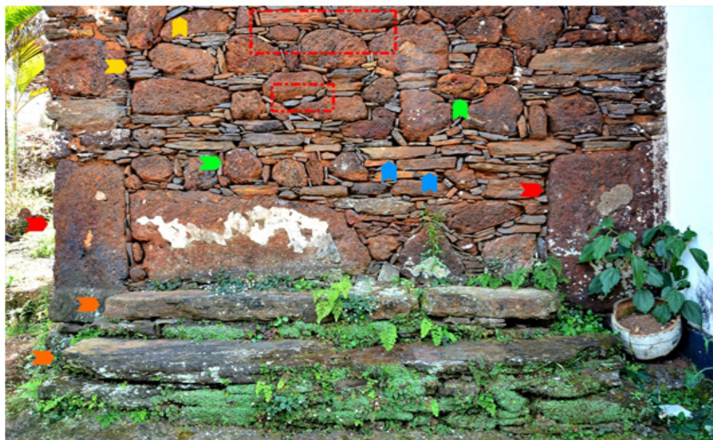
Figura 1 – Trecho de parede da capela-mor. Capela de Nossa Senhora da Conceição
