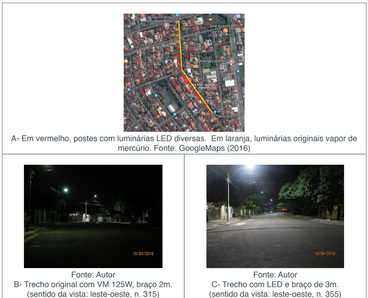
Figura 3 – (A, B, C) Aspectos visuais da substituição de sistemas de IP a VM por LED
