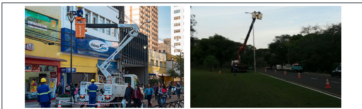
Figura 5 – Empresa 1, realizando substituição e manutenção de Luminárias diversas.
