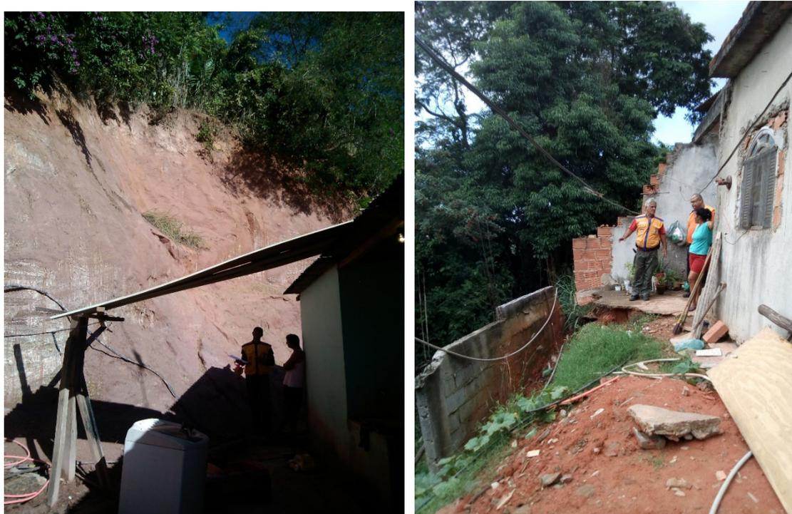
Figura 3 – Moradia posicionada na base do talude de corte sem condições apropriadas de estabilidade (esquerda) e construção posicionada no topo de barranco com as mesmas características (direita).
