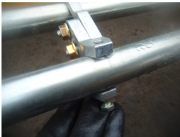
Figura 3 - Processo de inspeção com parafuso e a contra peça
