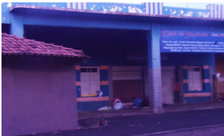
Figura 2. Área em frente a uma praça pública usada como abrigo por pessoas em situação de rua e pessoas que fazem uso de drogas.
