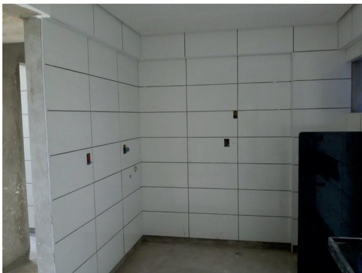
Figura 1 – Paginação do revestimento cerâmico na obra B.
