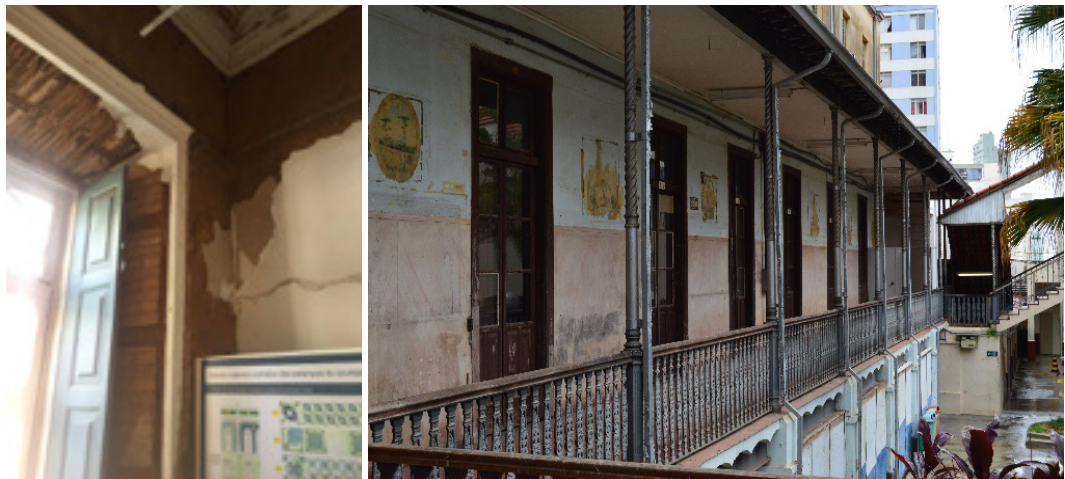
Figura 8: À esquerda, sobrado do Barão de Itatiba: detalhe construtivo de uma das paredes construída em taipa de pilão que encontra outra parede construída com a mesma técnica e encamisada com tijolos. À direita, residência do Barão de Itapura. Detalhe do alpendre junto ao jardim interno. Destaque para as abobadilhas de alvenaria de tijolos com vigas metálicas e para os elementos de ferro como gradis e colunelas. Fonte: Thaina Isabela Silva e Leonardo Rosa.
