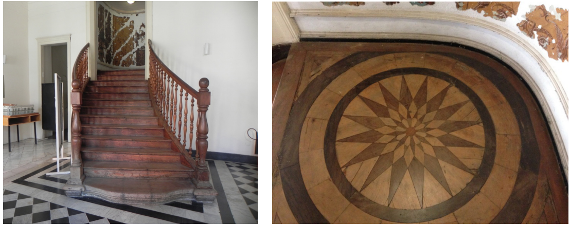
Figura 6: Palácio dos Azulejos – Vestíbulo. Detalhes da escada e do piso de marchetaria no patamar da escada.
