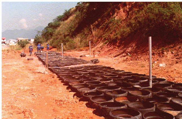
Figura 2. Lançamento da primeira camada de pneus na superfície (Sieira, 1998)
