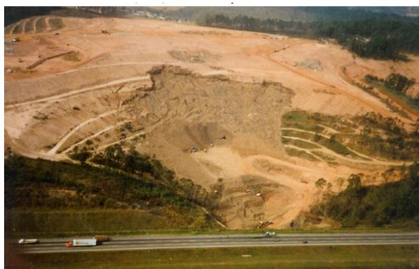
Figura 1. Escorregamento do aterro de Bandeirantes em 1991, (ITP, 1991).
