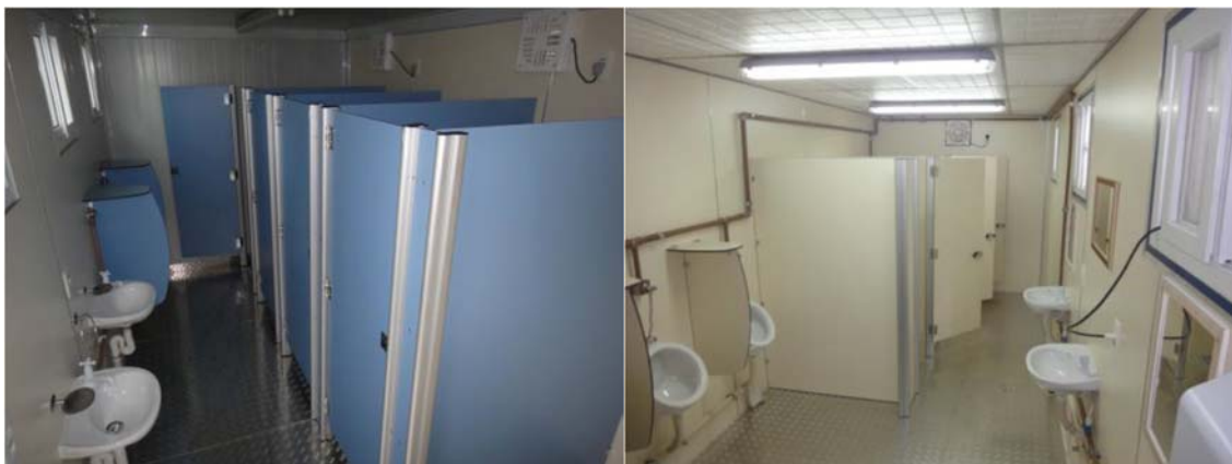
Figuras 03 - Banheiros no container
