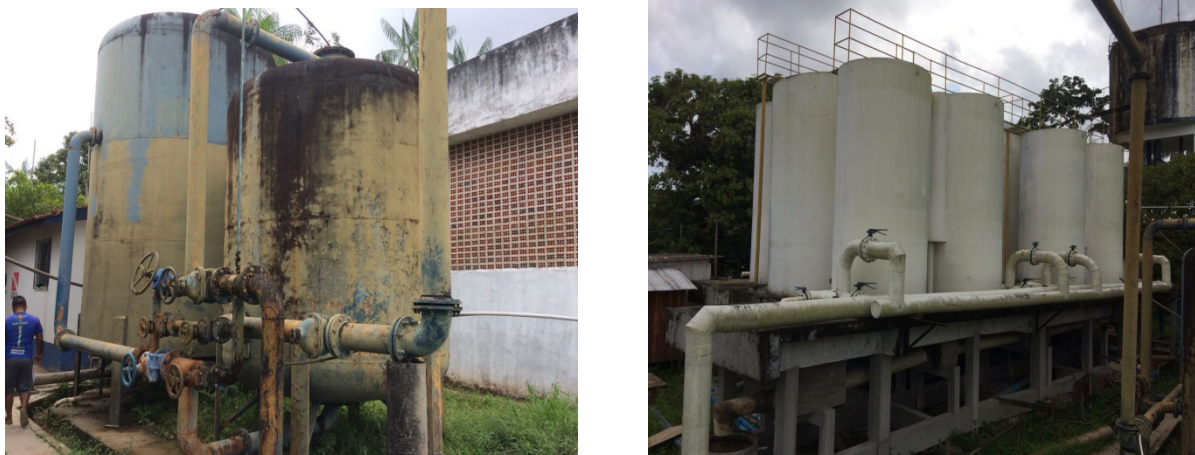
Figura 7. Tanques da Estação de Tratamento de Água - ETA da COSANPA que não estão em funcionamento no município de Afuá.
