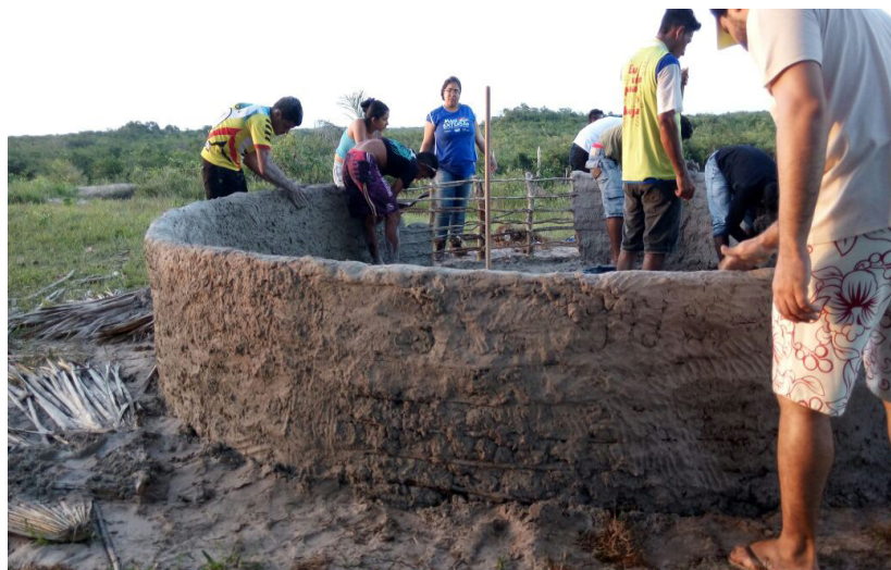
Figura 2. Sisteminha: Construção do tanque de taipa para piscicultura, CFR de Alegria, Primeira Cruz-MA
