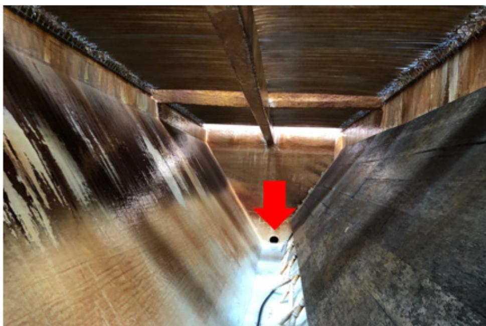
Figura 1: Válvula de descarga do decantador
