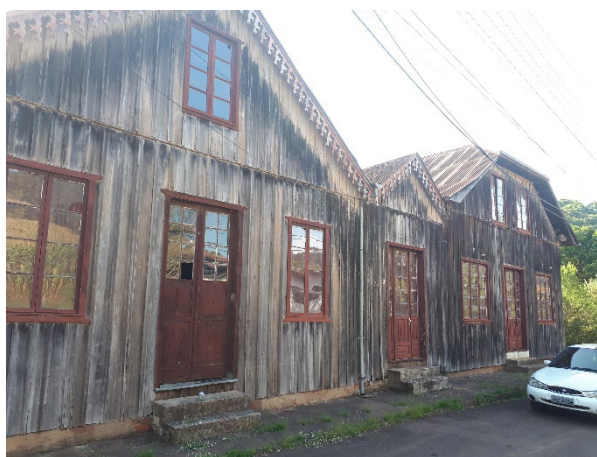
Figura 6– Casarão e Moinho da família Pulga, construções em madeira de araucária edificadas no fim do século XIX, representantes da influência da imigração italiana na arquitetura da região.
