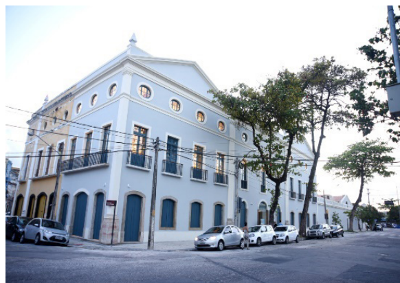
Figura 4 – Edifício Apolo 235 inaugurado em 2017 (Fonte: Porto Digital, 2017).
