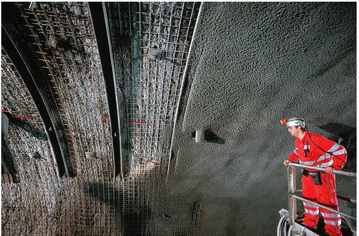
Figura 15 - Concreto projetado reforçado com cambotas metálicas e tirantes.
