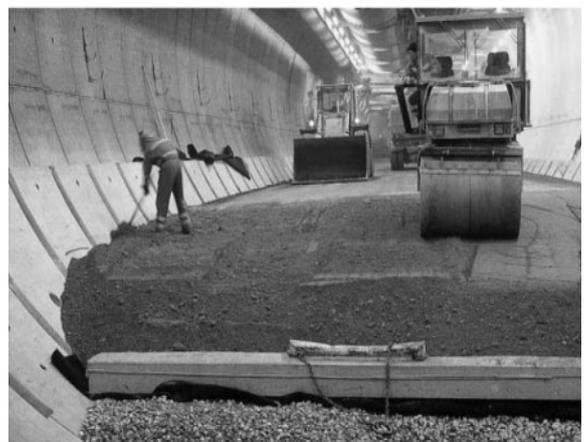
Figura 17 - Aterramento para pavimentação da pista de rodagem do túnel Murgenthal na cidade de Argovia, Suíça.
