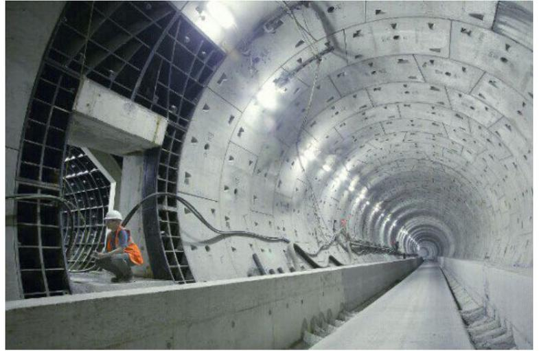
Figura 14 – Destaque para posicionamento e túnel finalizado com segmentos pré-moldados de concreto
