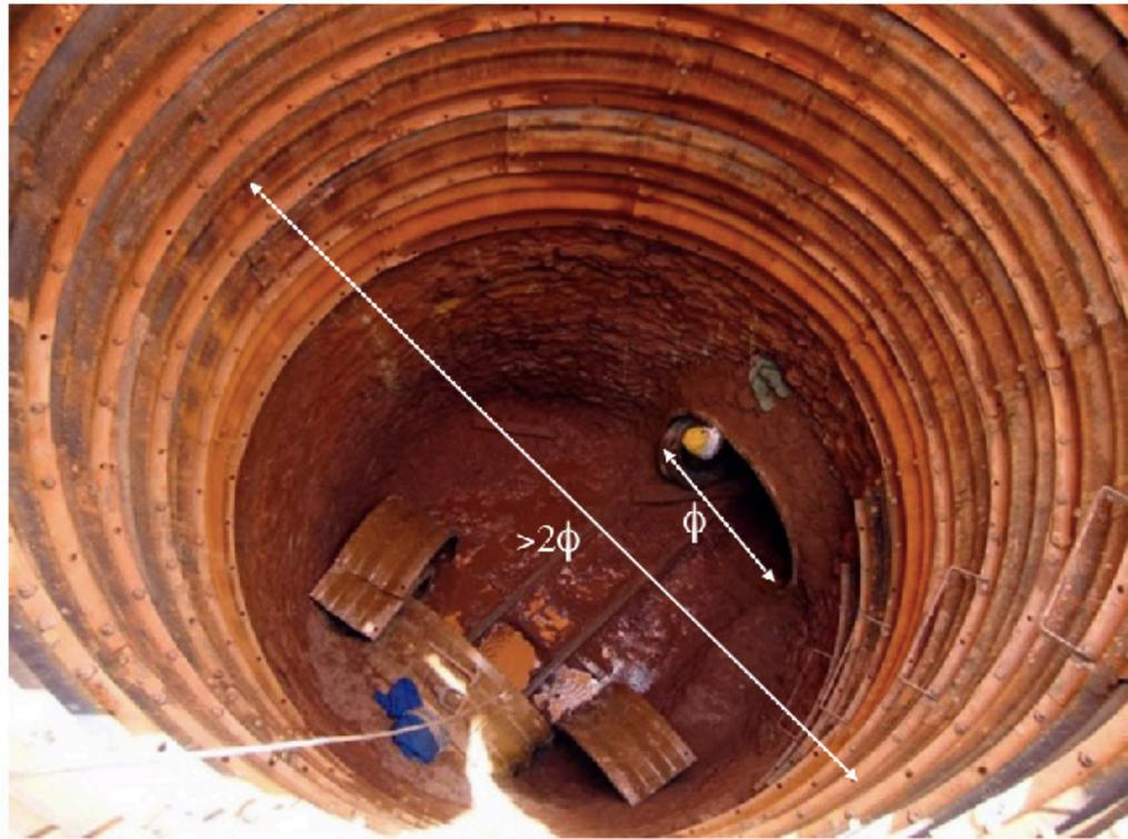
Figura 4 – Poço de ataque mostrando a relação do diâmetro do poço  $2f$  e do microtúnel que será escavado  $f$ .
