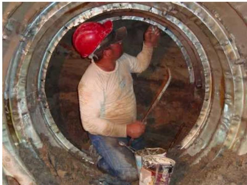
Figura 6 – Montagem das chapas metálicas.
