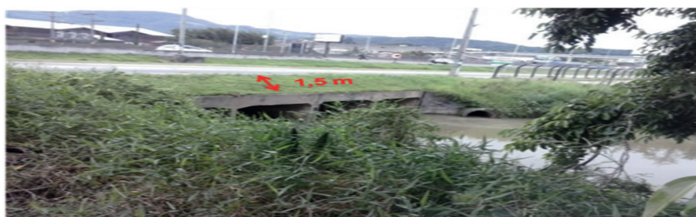
Figura 22 - Baixa cobertura sob a marginal da BR-101.
