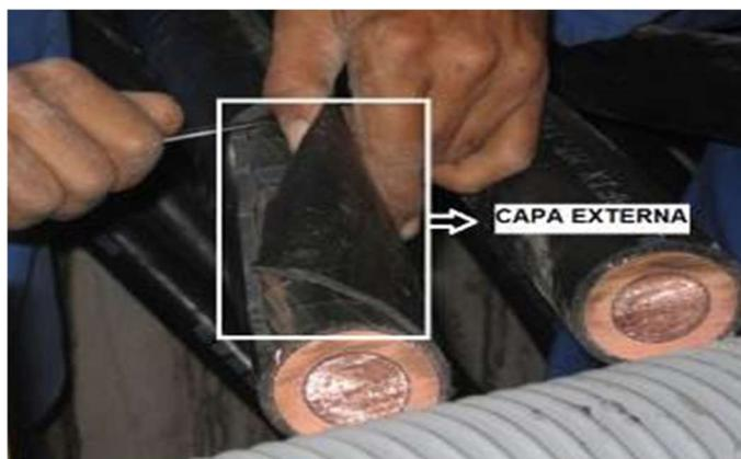
Figura 4- Retirada da capa externa do cabo.
