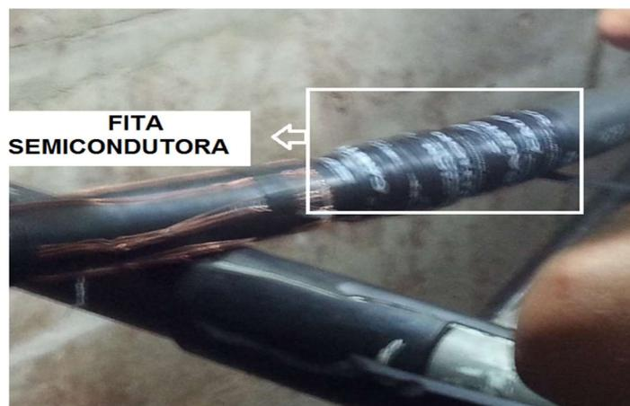
Figura 9- Aplicação da fita semicondutora no vão entre a cobertura externa e a isolamento.
