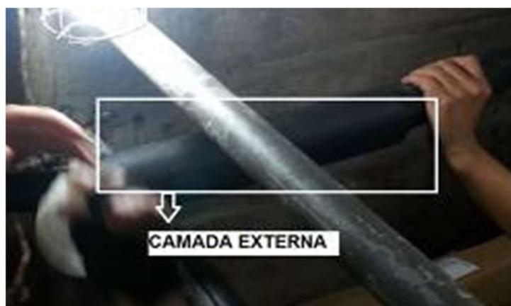
Figura 11- Aplicação da camada externa sobre a meia metálica.
