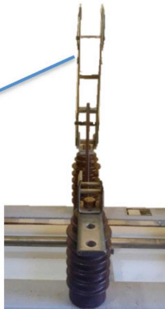
Figura 2 – Peça para reflexão do sinal de ultrassom
