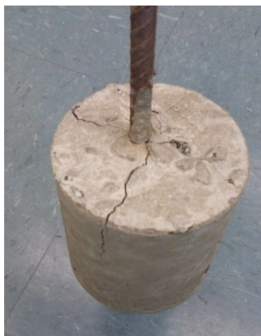
Figura 9 - Ruptura do corpo de prova de concreto convencional Fonte: Autora, 2016.
