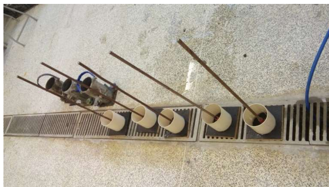
Figura 4 - Moldes montados antes da concretagem Fonte: Autora, 2016.
