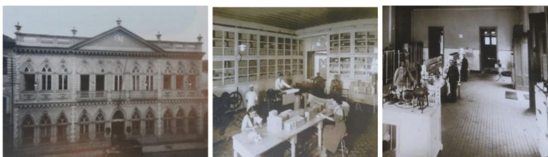
Figuras 14, 15 e 16: Fachada do edifício principal do Laboratório Chimico Pharmaceutico voltado para rua Evaristo da Veiga; fotos internas do laboratório em funcionamento. Crédito: João Paulo Vieira e Eduardo Pinto.
