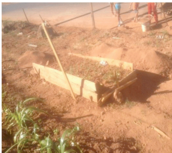
Figura 10: Construção dos canteiros no solo. (Fonte: Autores, 2017)
