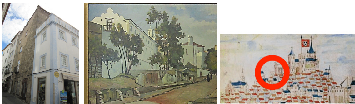
Fig. 29 – Torre do Anjo – na antiga rua da Selaria que tinha fronteira outra torre, demolida com a qual constituíam a Porta da Praça Grande.
