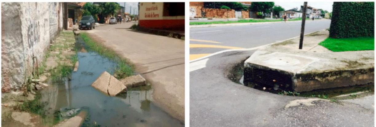
Figura 1 – Bueiro submerso devido a obstrução ocorrida. Figura 2 – Boca de lobo com boa infraestrutura, porém mal posicionado.
