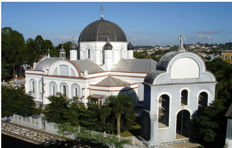
Figura 8 – Igreja São Josafat, área central do município de Prudentópolis-PR.
