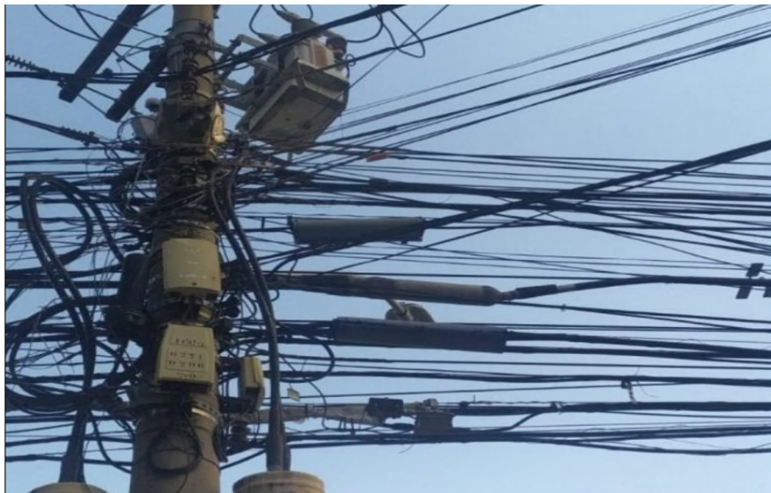
Figura 4 – Evidência visual de sobrecarga, sobreposição de cabos e desordem na infraestrutura aérea urbana, identificada por inspeção visual apoiada por VANT.
