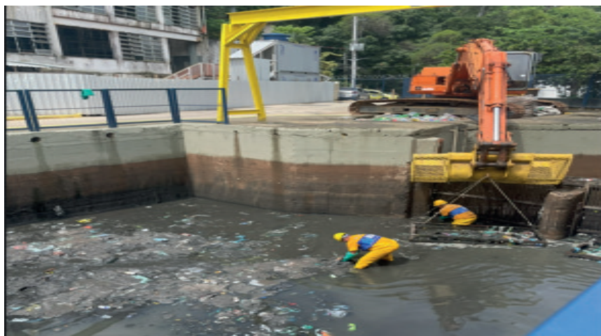
Figura 3: Trabalhadores fazendo a retirada dos resíduos no canal de drenagem após forte chuva.
